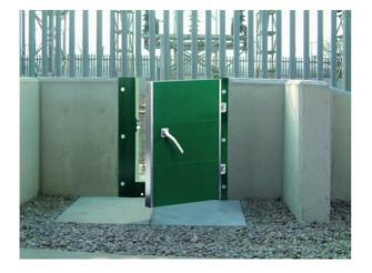
Figure 39 Utility application of a flood door (www.hochwasserschutz-rs.de/en/flutschutz-turen-fst-s-2)
