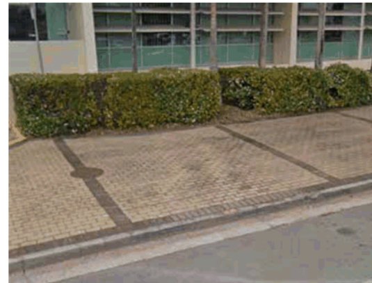
Existing Site Manhole
